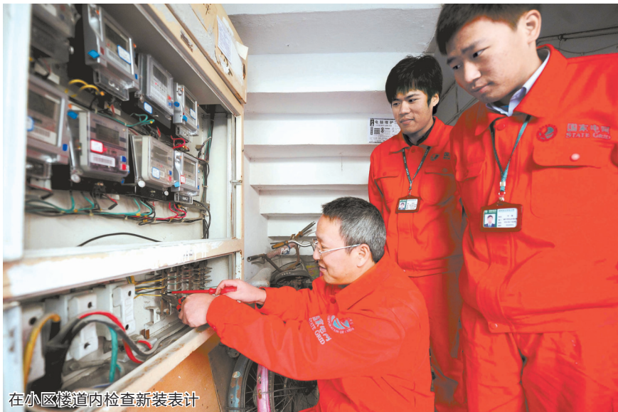
在小区楼道内检查新装表计
