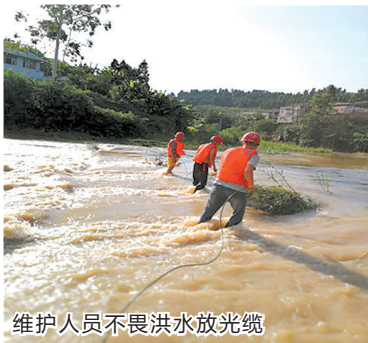
维护人员不畏洪水放光缆
