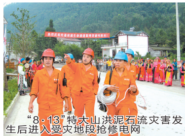
“8·13”特大山洪泥石流灾害发生后进入受灾地段抢修电网
