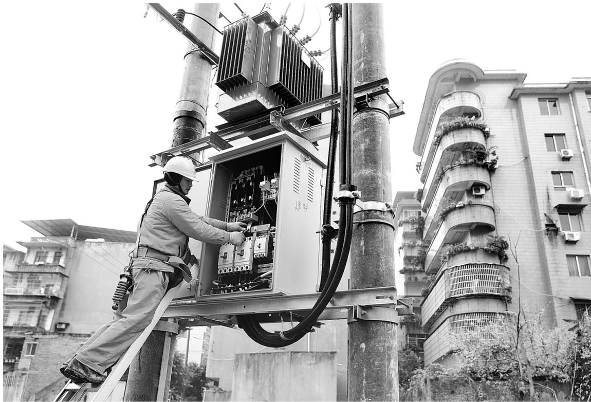
春节临近,四川省华蓥市供电公司针对一些居民小区供电设施陈旧、电源线路老化和安全隐患突出等现象,组织专门的队伍实施配电设施改造工程,及时织好“电网”,确保居民在新春佳节用电安全。图为1月9日,“电力蜘蛛侠”冒着寒风在明光二路小区测试新安装的配电设施。
