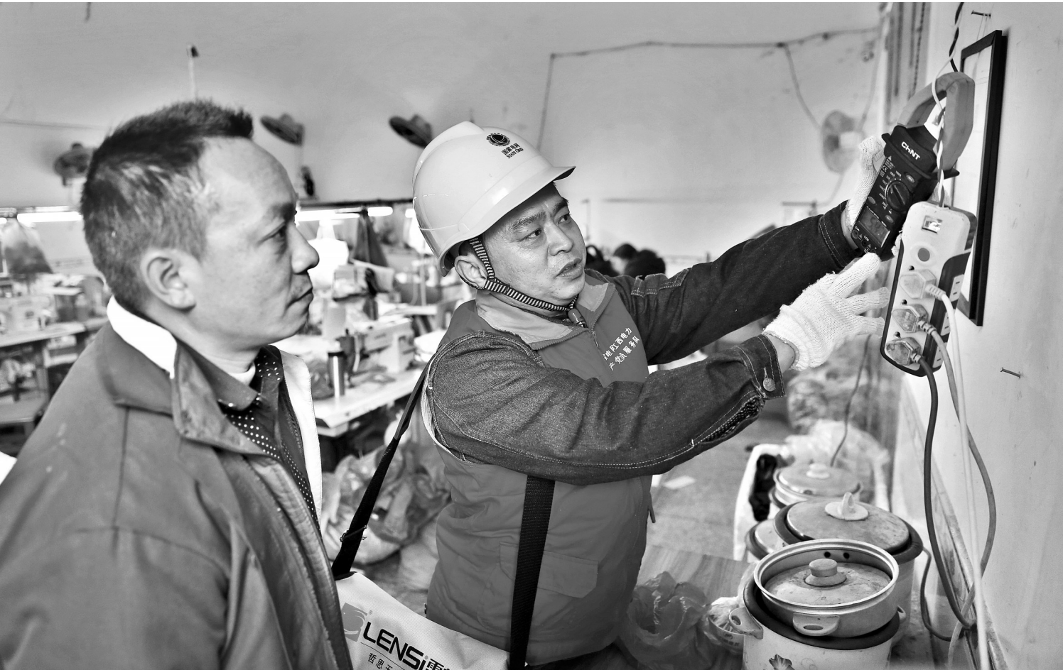
3月5日，江西省永丰县供电公司电力党员服务队深入多家民营企业，为他们维修机电设备、更换破损电线并宣传安全用电、节约用电知识。图为党员服务队队员在一家民营企业检修电线。 刘浩军 彭臻华 摄
