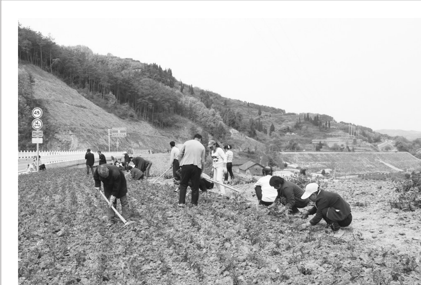
连日来,在湖北省丹江口市环库公路江南段新建成通车的22公里的路上,道路绿化部门组织人员在路边栽玫瑰花、杜鹃花。据悉,整条公路在建设初期按照生态、环保、旅游公路标准建设,“三季有花、四季见绿”的景观设计是丹江口环库公路的另一大特色,优先考虑移植或栽培本土植物。图为4月7日,丹江口市牛河林区凤凰山路段,民工在路边栽玫瑰花。
