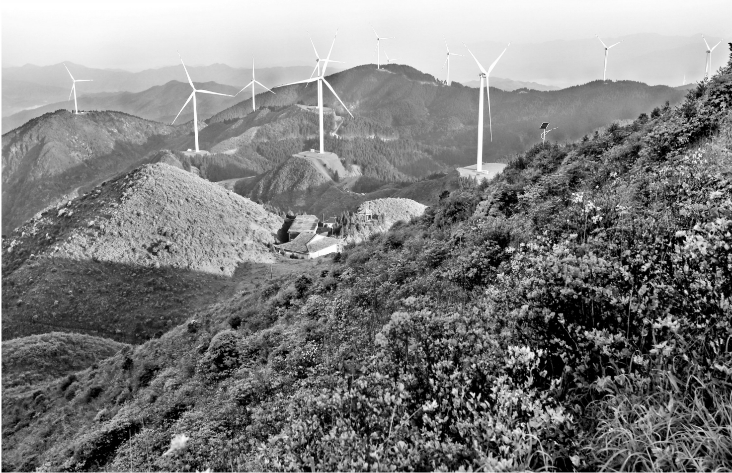
近年来,江西省吉安市永丰县坚持以绿色发展理念,着力推进风力发电、水力发电、光伏发电等清洁能源开发,为乡村振兴提供充足的电力保障,在生态保护和电力扶贫两方面发挥积极作用。图为吉安市永丰县中村乡凌云山的风电园。
