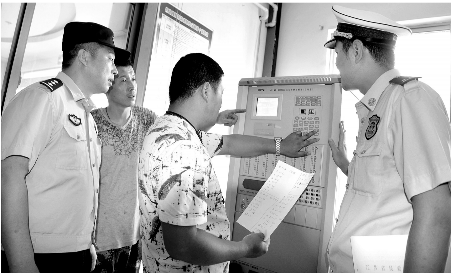
7月3日,江苏省连云港高新区花果山街道、高新区消防救援大队、高新公安分局花果山派出所等深入花果山辖区,对老年公寓的餐厅、宿舍、楼道逐一排查,重点对用火、用电、用气管理,消防设施的配置、保养与使用情况进行了检查,提高了老年公寓工作人员的消防安全意识,让老人们安心安稳度过夏季。图为公安消防人员在检查消防控制主机电柜的正常运行情况。 赵俊摄
