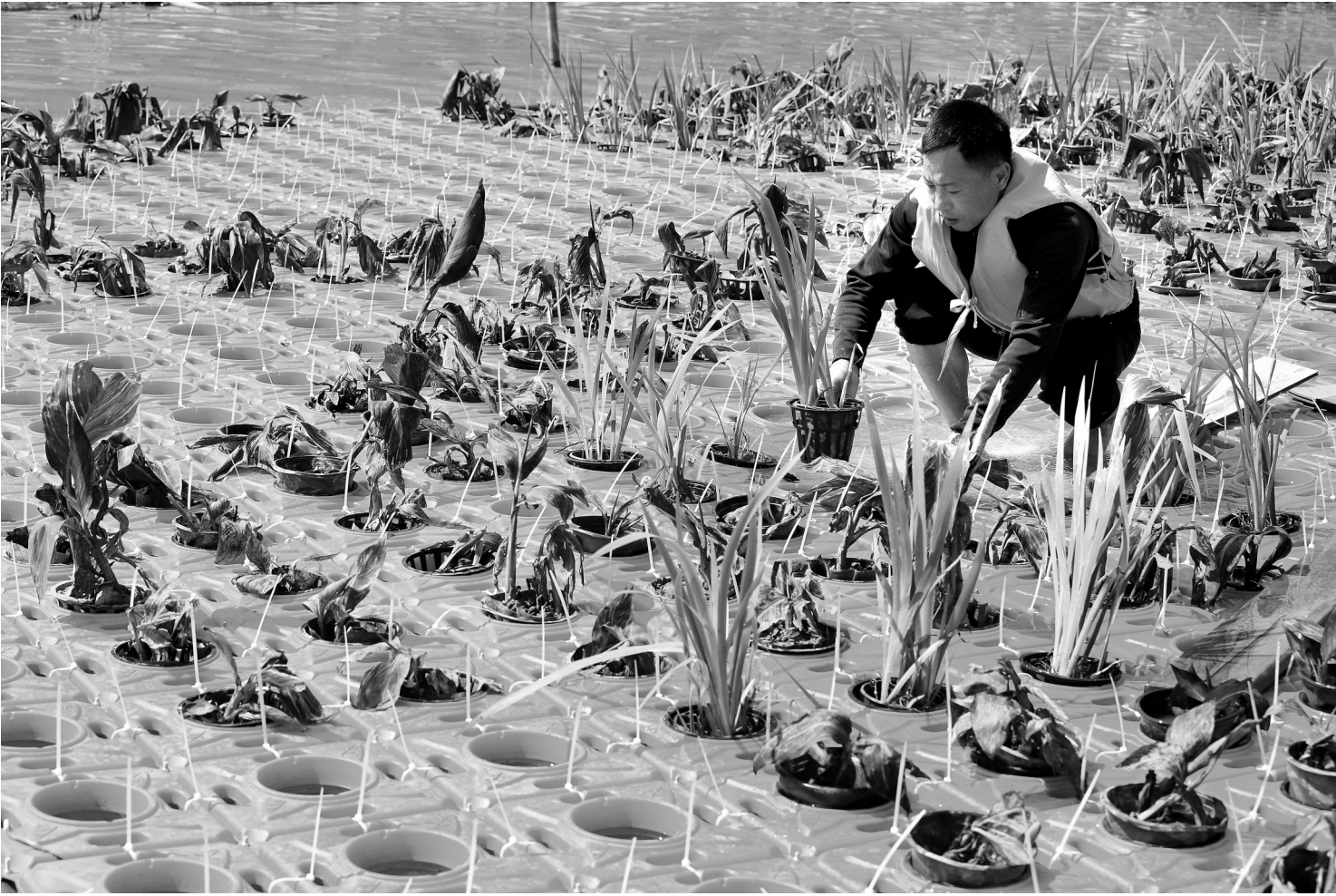
为了在高温天气下净化水质，更好地防止蓝藻生长，最近一周，浙江环湖生态建设有限公司的工人们已在长达2公里的浙江省湖州市苕溪港环城河河段陆续搭建了100多个大大小小的浮岛，并种植了荷花等景观植物。图为4月28日，工人在环城河的浮岛上栽种美人蕉、翠芦莉、水美人等各类水生植物。邓德华 摄
