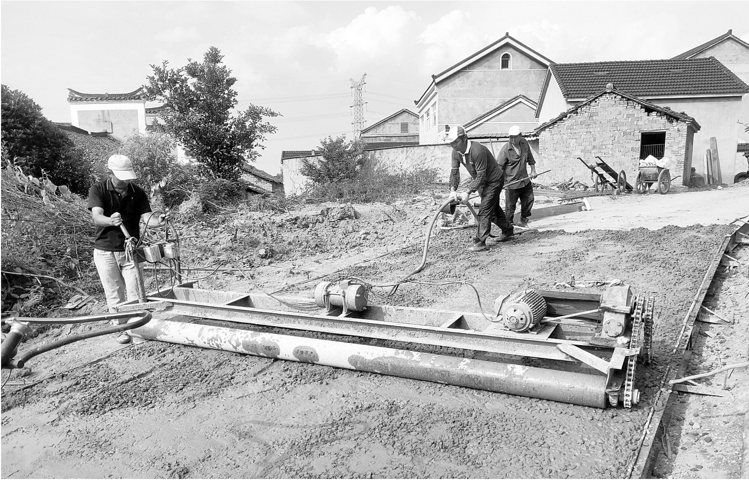
近年来,安徽省怀宁县以建设“四好农村路”为抓手,加快推进农村公路建、管、护、运营协调可持续发展,为打好精准脱贫攻坚战提供坚实的交通运输保障。图为5月12日,该县腊树镇容岭村施工队伍正加快速度建设苏屋组“四好农村路”。钱续坤 孙李娜 摄
