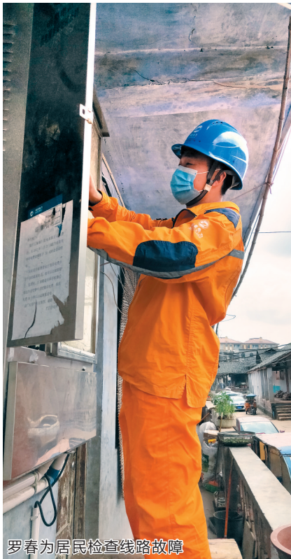
罗春为居民检查线路故障
