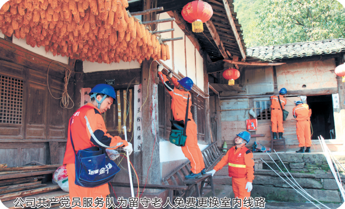
公司共产党员服务队为留守老人免费更换室内线路
