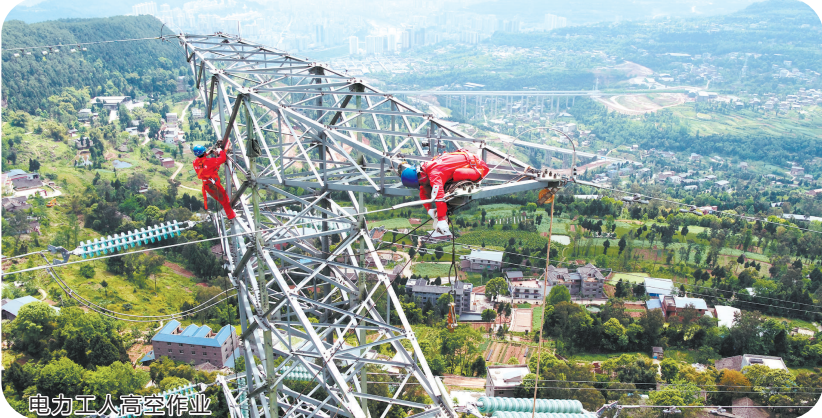
电力工人高空作业
