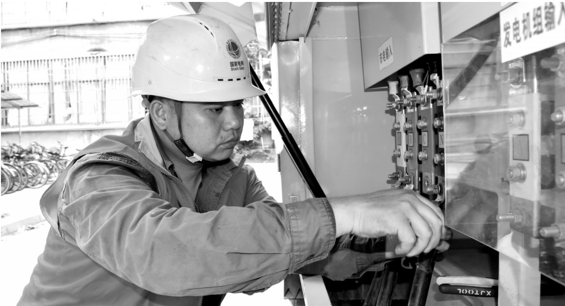
为保证高考用电万无一失，考生顺利应考，近日，国网江西省电力公司遂川县供电公司组织了高考保电小组对两处考点开展专项隐患排查，保证高考期间电网安全稳定运行。图为遂川县供电公司的党员服务队在遂川中学高考点检查线路。 李建平 高远秋 摄
