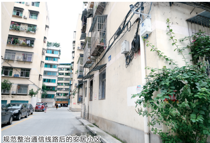
规范整治通信线路后的安居小区
