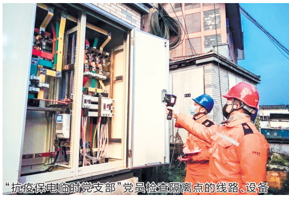
“抗疫保电临时党支部”党员检查隔离点的线路、设备
