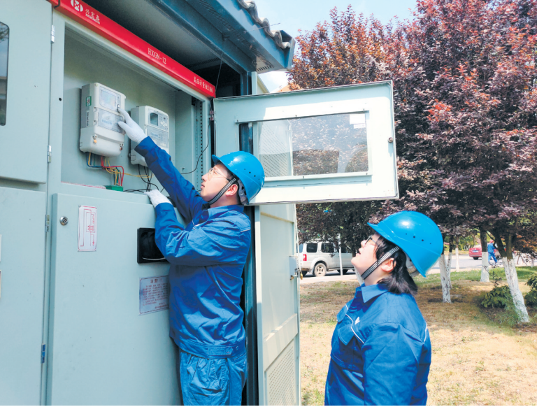
开展迎峰度夏供电安全检修
