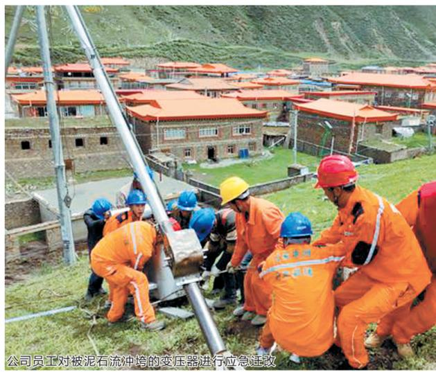
公司员工对被泥石流冲垮的变压器进行紧急抢修
