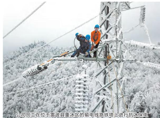
公司员工在位于雷波县重冰区的输电线路铁塔上进行抗冰保电
