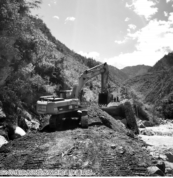
G247线凉水河坝水毁点抢通保通现场
