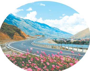
道孚303线过境公路
