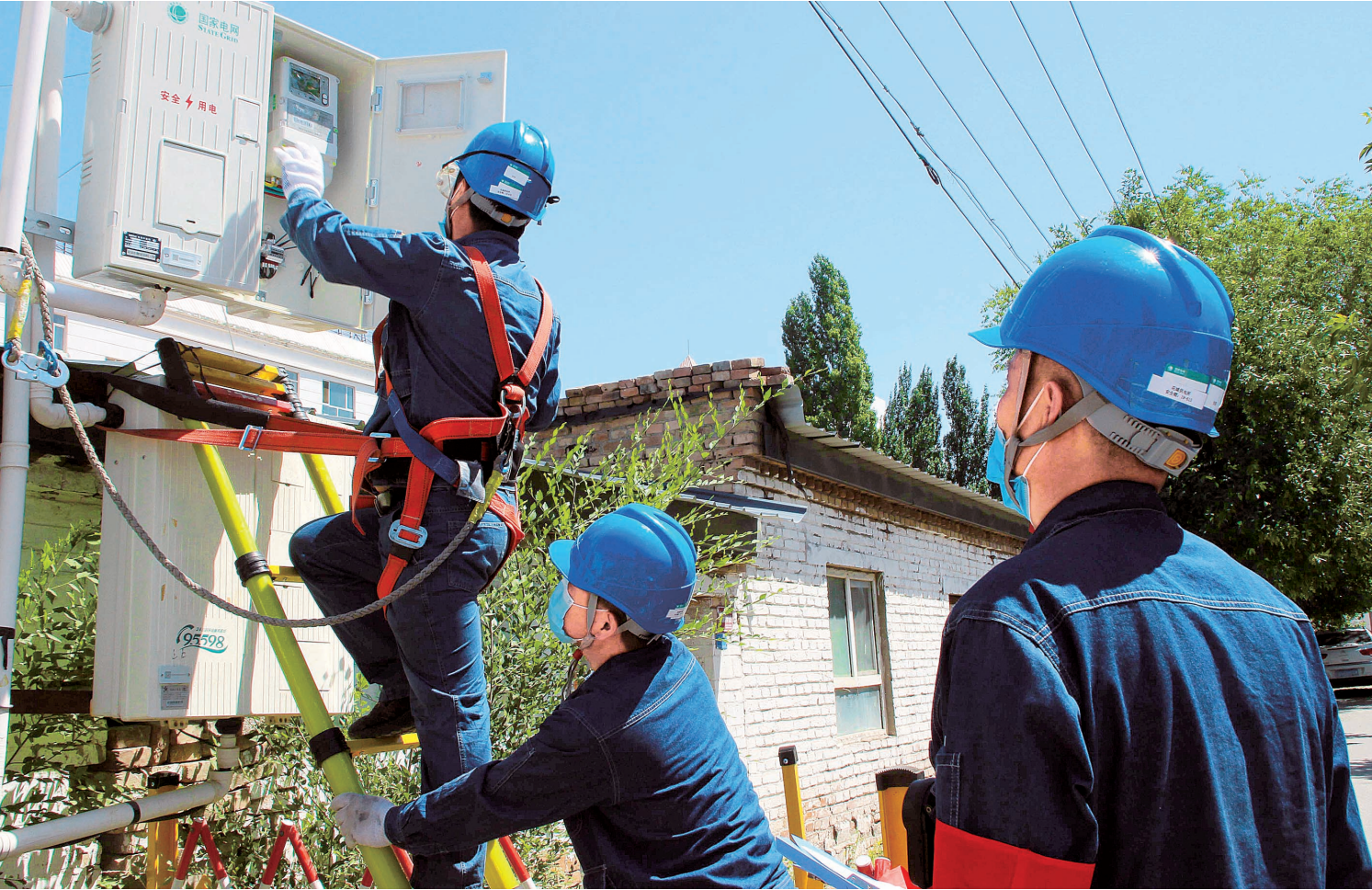
连日来，新疆裕民县出现持续高温天气，国网新疆裕民县供电公司一线员工加大电网巡检力度，保障夏季供电安全，让居民用电无忧。图为7月6日，国网新疆裕民县供电公司的员工在高温天气下检查电网线路。
