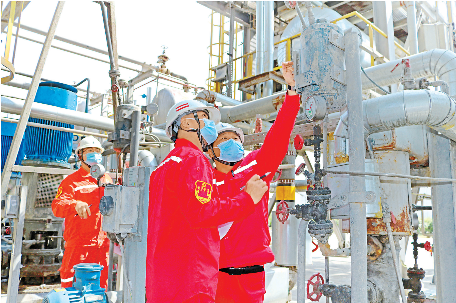
为做好极端天气和地质灾害安全防范，中国石化中原油田天然气处理厂党委积极发挥基层党组织和党员的示范引领作用，对天然气生产装置开展排水疏通、防雷防静电等措施排查，全力维护人员生命安全和装置安全。图为6月26日，基层党员在装置现场排查安全隐患。 赵奕松 蔺庆 摄
