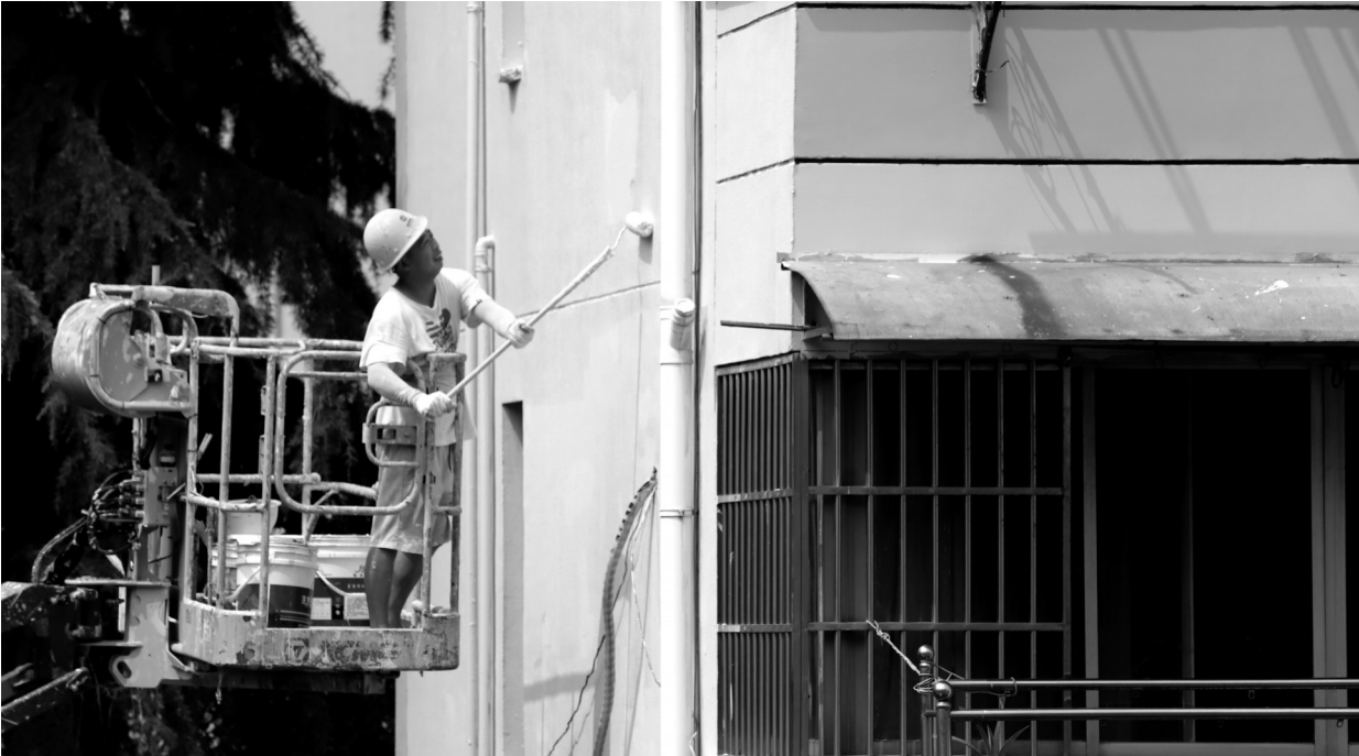
老旧小区改造是浙江省湖州市今年的重点民生实事项目之一。今年,该市计划改造老旧小区42个,总投资约7亿元,涉及约685栋居民楼共1.9万户居民,总面积达147万平方米,目前已经全面开工,到明年下半年全面完工。图为7月24日,在湖州市南太湖新区凤凰街道凤凰二村,工人冒着高温对老旧小区居民楼外立面墙体进行粉刷。 邓德华 摄
