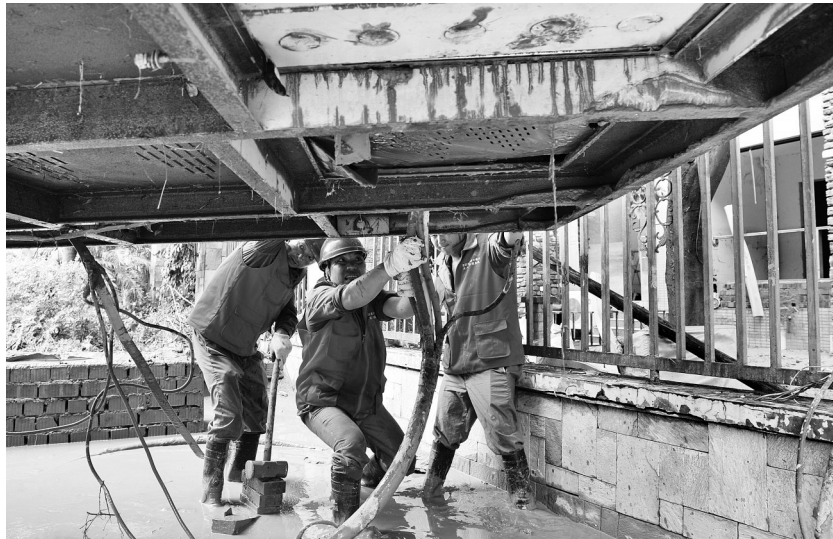
在金堂抗洪保电中对停电小区开展抢修。
