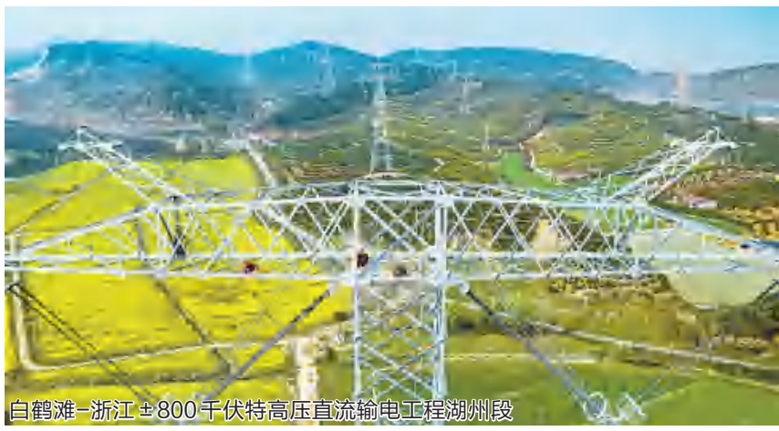
白鹤滩-浙江±800千伏特高压直流输电工程湖州段
