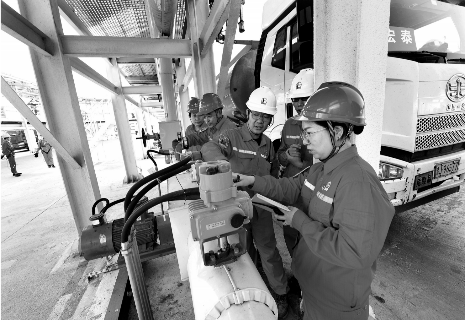
5月初以来,中国石化中原油田油气储运中心开展为期两个月的“凝心聚力提能增效 全面完成洛阳炼油厂检修期间原油运销任务”会战,柳屯中心处理站党支部组建了党员攻坚队,在提高生产效率、破解生产难题方面发挥“领头雁”作用。图为5月23日,柳屯中心处理站党员在原油装车岗开展党员立项攻关,解决设备计量表存在的问题。
