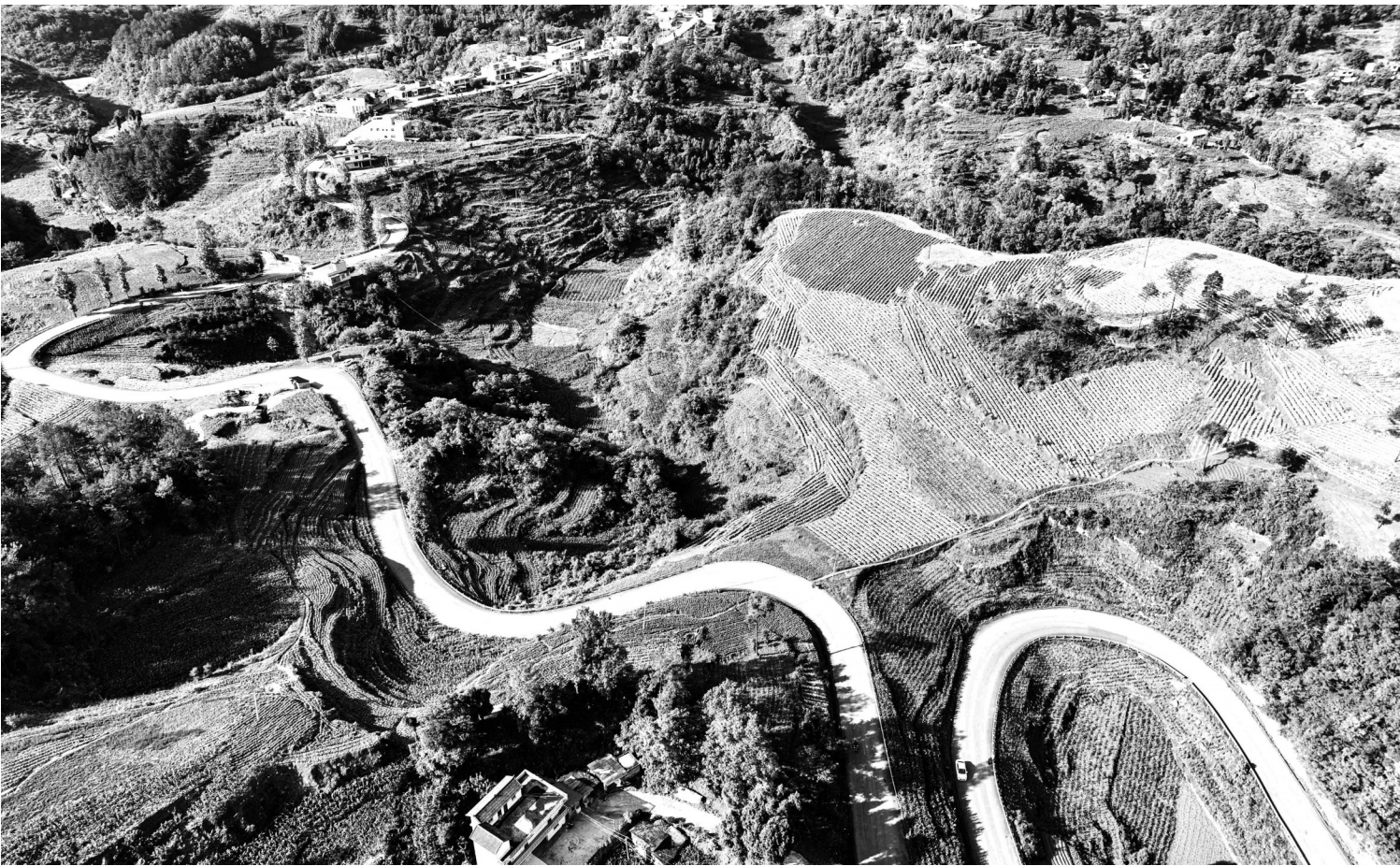
近年来,贵州省黔西市实施农村公路建设,全面打通农村路网“毛细血管”,建立市通乡镇、乡镇通村、村通组公路稳定、长效的养护机制,围绕农村公路“建好、管好、护好、运营好”的总目标,持续优化瓶颈路段,助力乡村振兴。图为6月6日,航拍永荣彝族苗族乡打底村境内蜿蜒盘旋的“四好农村路”。 周川超 摄
