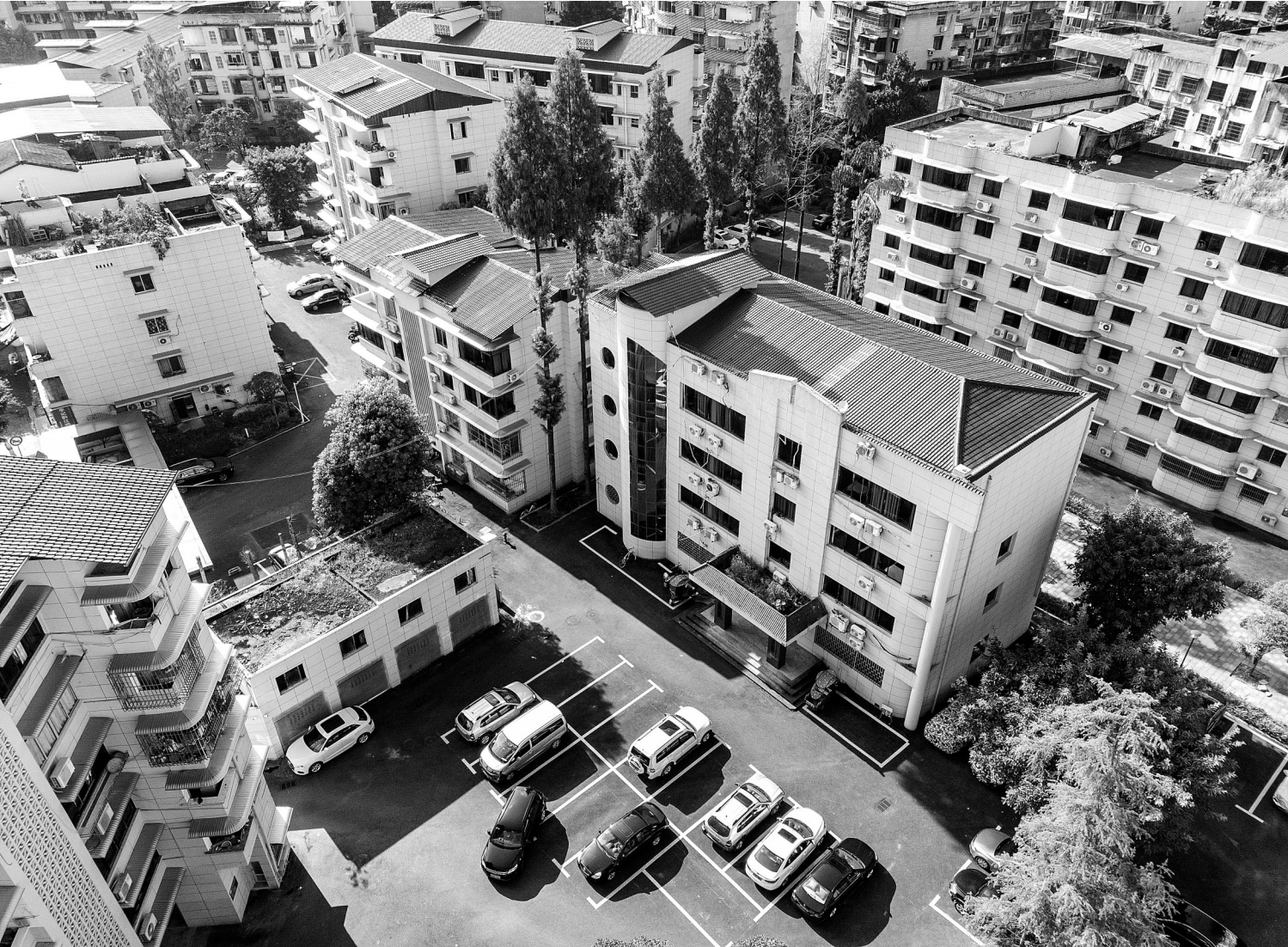
重庆市垫江县桂溪街道的七星家园20世纪80年代建成，共427户，建筑面积50400平方米。市政府通过对该小区居民楼进行墙面翻新、排水管网、供水管线、燃气管线等翻新改造。并增设消防栓、智能安防系统、充电桩、停车位、路灯、绿化景观，让这个老旧小区焕发出新活力。图为翻新改造后的小区环境。
