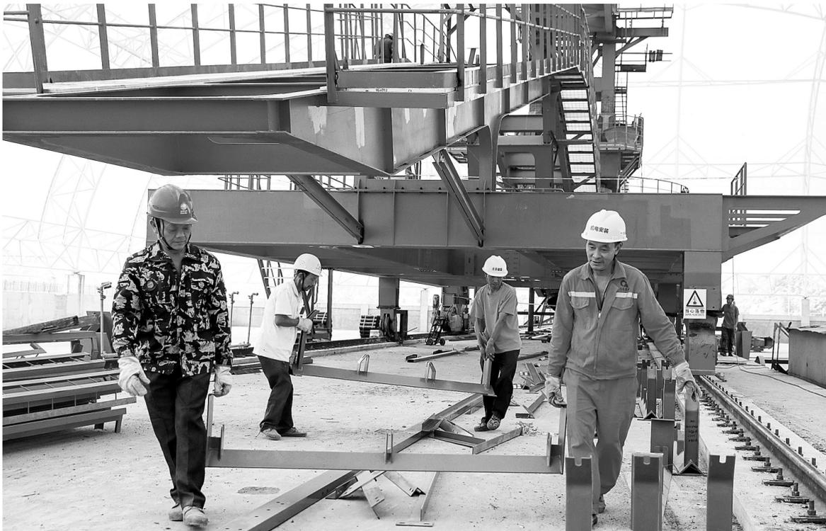
8月30日，四川省首个国家级煤炭储备基地、川渝两地共建20个重大能源项目之一的广安市高兴煤炭储备基地建设项目正式通过竣工验收。目前正在进行煤棚内堆料机、传送带等设备安装，预计9月底整个项目全面竣工并投入运行。投入运行后将进一步满足四川省、重庆市煤炭供应应急保障，助力成渝地区双城经济圈建设。图为工人正在安装传送带支架。 邱海鹰 摄
