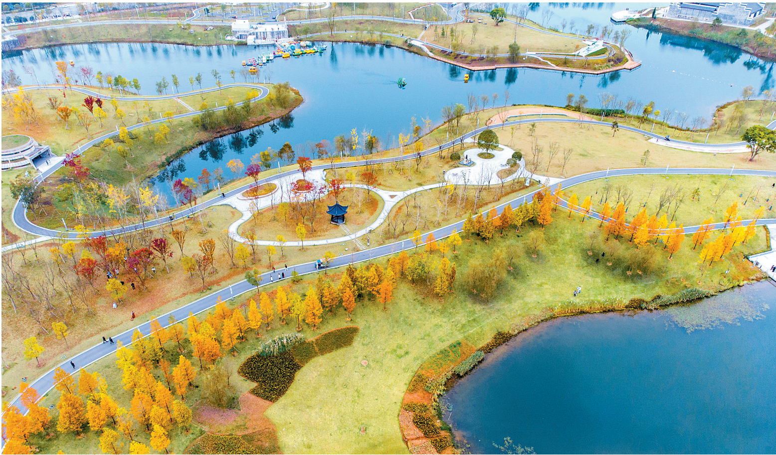
近年来,重庆市垫江县坚定不移走生态优先、绿色发展之路,在城市建设中融入绿色城市、智慧城市、山海海绵城市等理念,让城区成为“会呼吸的海绵体”,构建城市与自然和谐共生的新形态。图为11月18日,重庆市垫江县东部新区的三合湖湿地公园,五彩斑斓,风景如画。孙凯芳 摄
