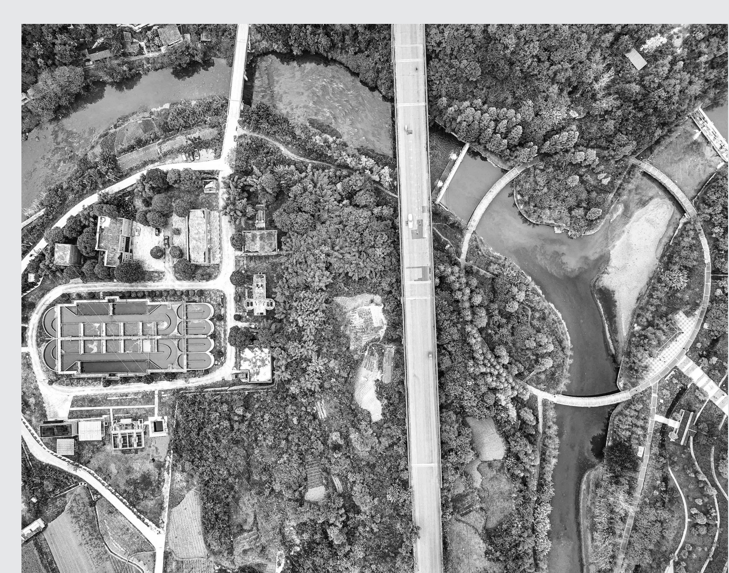
近年来,贵州省黔西市全面落实河长制,制订并实施“一河一策”治理方案,以水污染治理、水生态修复、水质改善为重点,大力排查污染源,建设污水处理厂和实施改扩建工程,全面提升污水收集率、污水处理率和达标率,各河流水质日益改善,呈现出水清岸绿美景。图为11月5日,航拍莲城街道水西半岛的污水处理厂,尾水净化后的河水清澈,岸边树木秋意正浓,景色如画。
