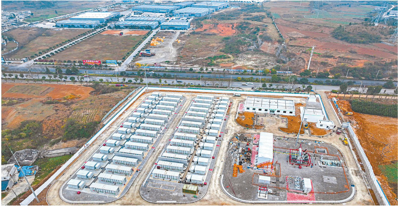
即将建成投入使用的贵州省黔西市文峰街道兴黔社区新能源储能电站占地27.5亩,是黔西市目前最大的“充电宝”,项目总投资3.5亿元,充放功率110.88兆瓦,存储容量193.6兆瓦时。该新能源储能电站在用电低谷时“插在”电网上充电,在用电高峰期时释放电力,有效填补该市用电缺口。图为12月15日,航拍的文峰街道兴黔社区即将投入使用的新能源储能电站。
