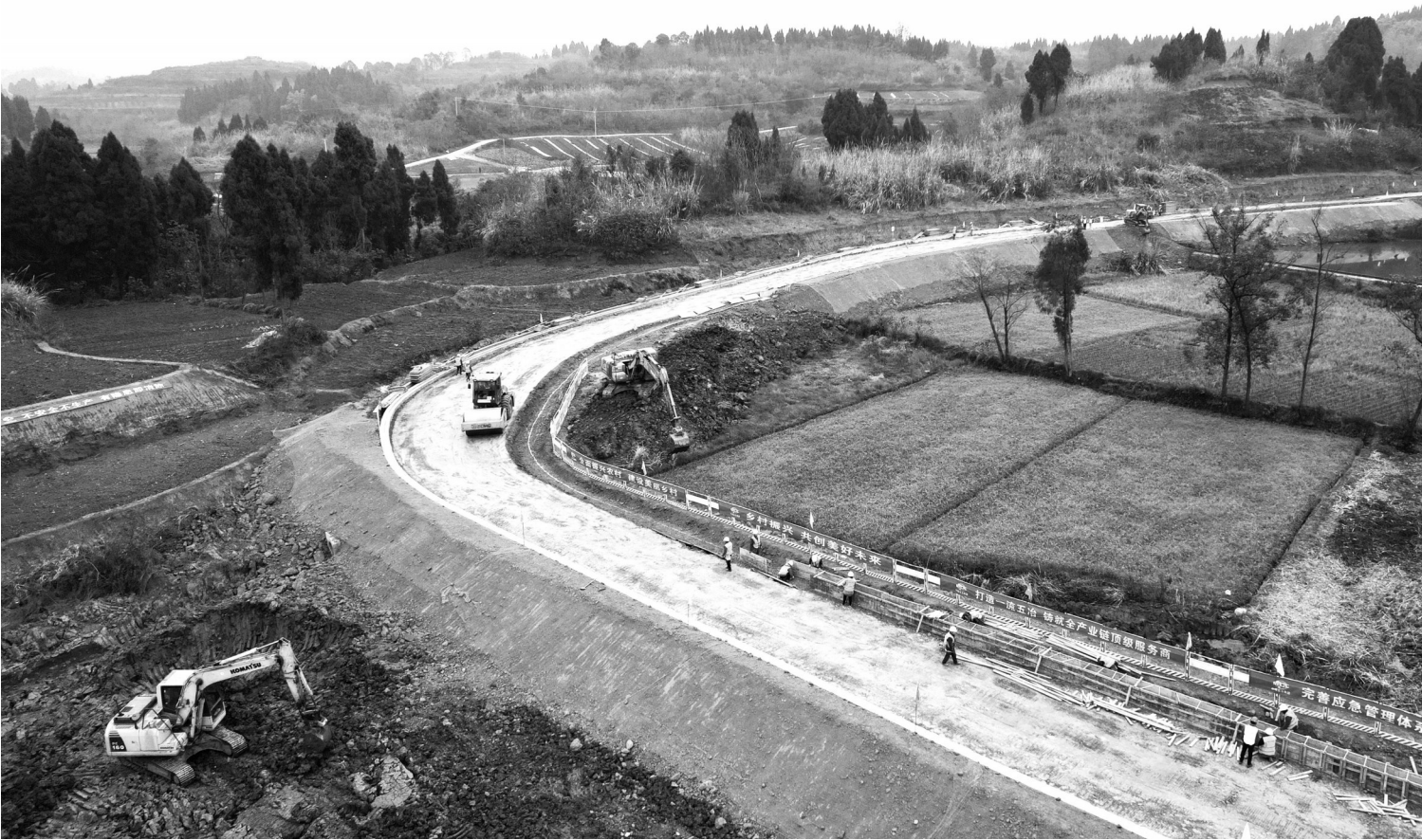
近年来,四川省内江市东兴区大力推进现代农业示范园区建设,积极探索创新机制,以长江现代农业园区为核心,整合资源资金加快推进园区环线公路建设、人居环境整治、高标准农田建设、主导产业发展等项目建设,为农民增收致富,农业提质增效打下良好基础。图为12月21日,在位于内江市东兴区田家镇旦家村的长江现代农业园区环线公路施工现场,中国五冶集团的建设者正在加紧施工。
