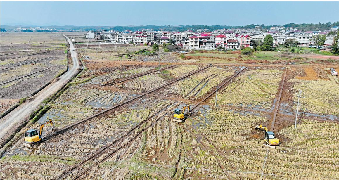
近年来,江西省永丰县持续推进高标准农田建设,同步平整水灌区耕地、铺设田间机耕道和修建灌溉排涝渠道,着力改善农业生态环境,巩固和扩大粮食旱涝保收面积,保障粮食安全,助力乡村振兴。图为1月15日,永丰县佐龙乡野溪水库灌区,工人正在操作机械进行农田整治施工。
