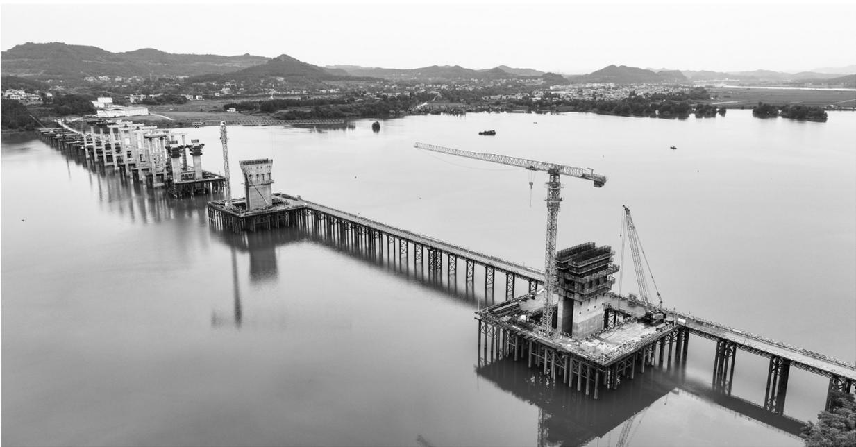
6月9日,在四川省阆中市阆(中)营(山)高速公路嘉陵江特大桥项目工地,工人们正在忙碌作业,现场一派热火朝天的施工景象。目前,大桥主墩墩柱施工已经完成,标志着大桥进入主墩梁部施工阶段。
