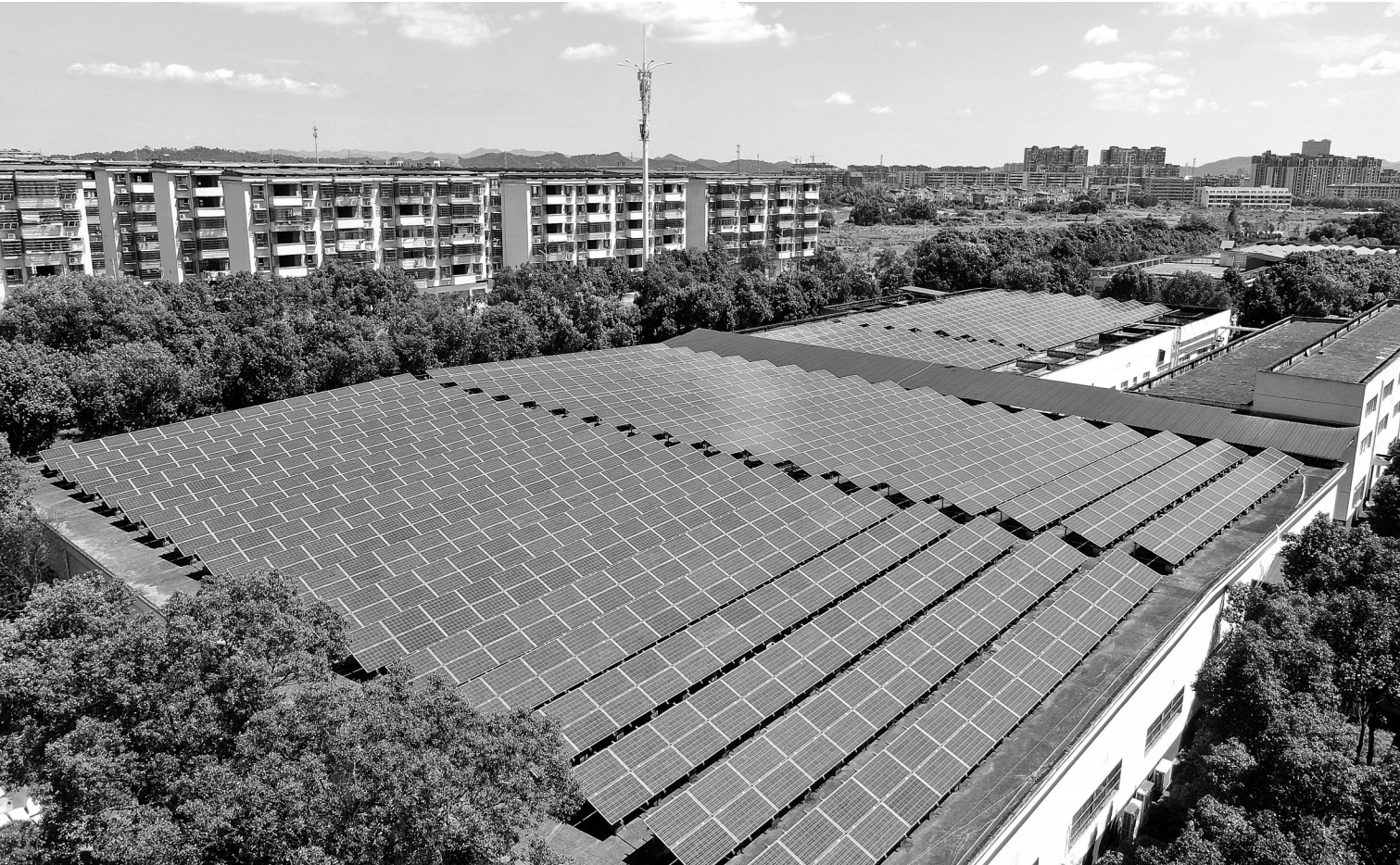
近年来,江西省峡江县坚持生态优先、绿色发展理念,鼓励企业厂房、办公楼推进屋顶光伏发电项目建设,将清洁电能用于生产运行,为企业绿色低碳、环保发展注入清洁动能。图为7月4日,峡江县普正药业公司厂房屋顶,整齐划一的蓝色太阳能光伏板在阳光下熠熠生辉,源源不断地产生清洁电能。
