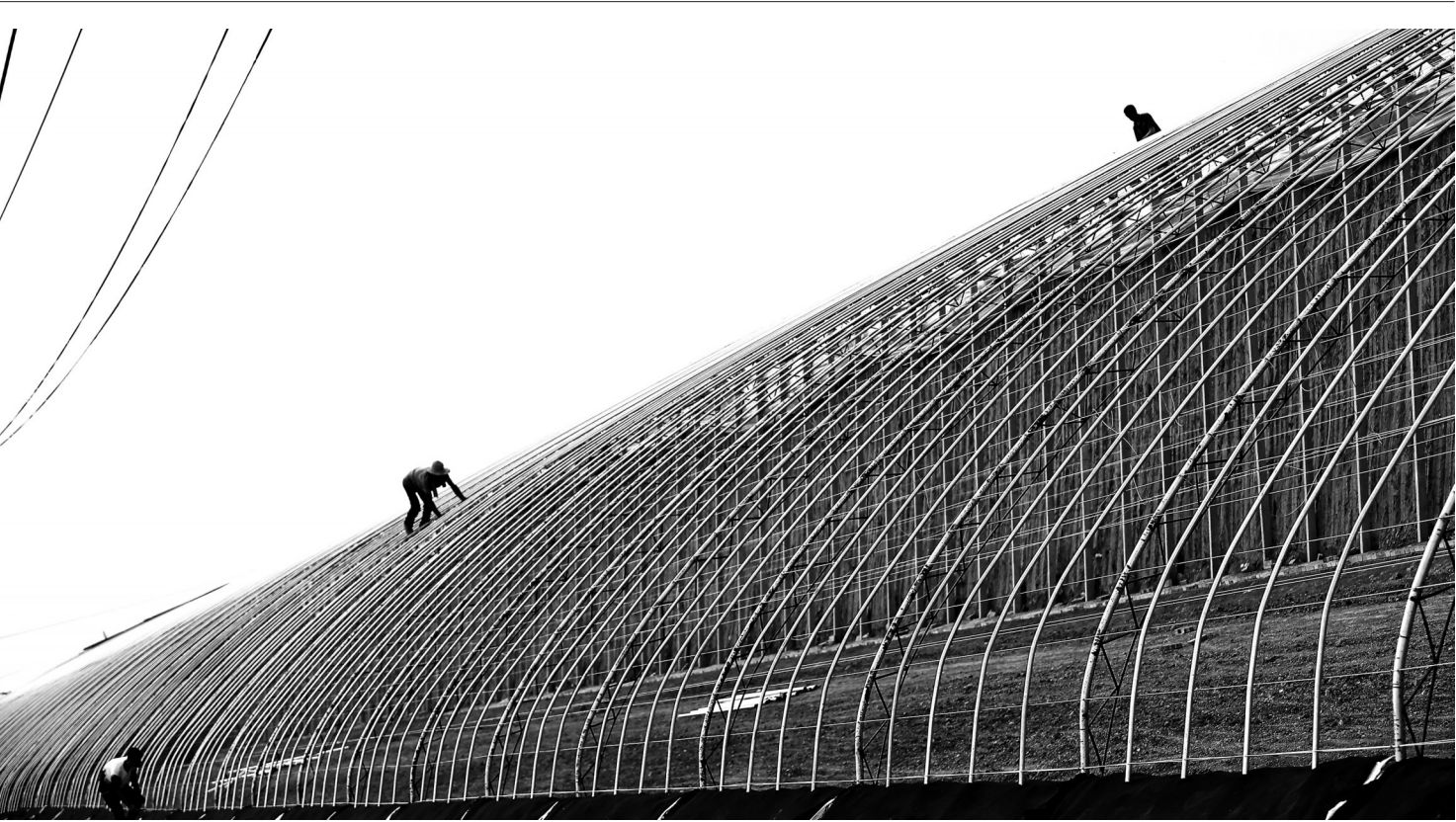
9月9日,山西省设施蔬菜大县运城市新绛县,数百个日光温室设施蔬菜秋季新建、扩建和加固提升作业现场如火如荼。图为三泉镇南熟汾村村民在加紧建设设施蔬菜大棚。 高新生 摄
