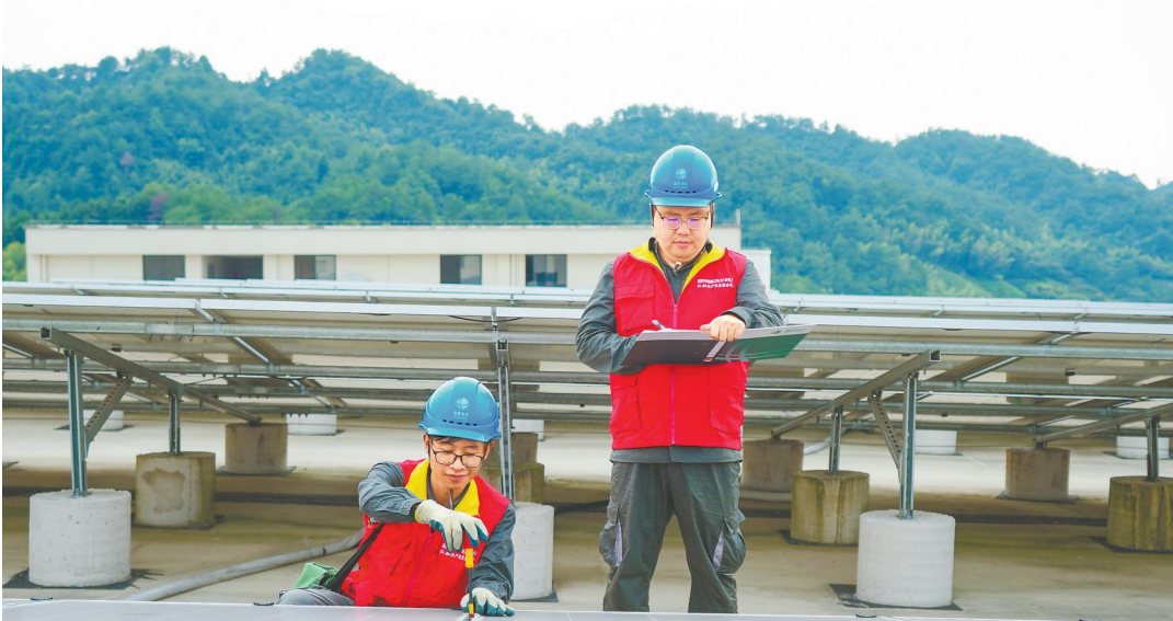
国网安吉县供电公司工作人员排查企业屋顶光伏发电情况，排除风险隐患。
