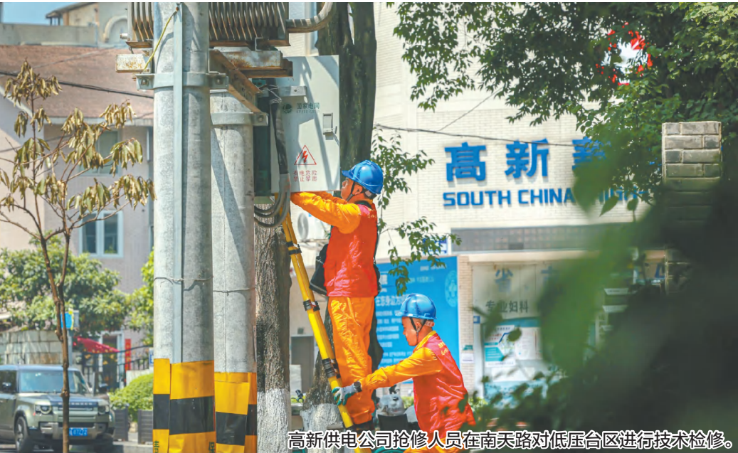
高新供电公司抢修人员在南路对低压台区进行技术检修。
