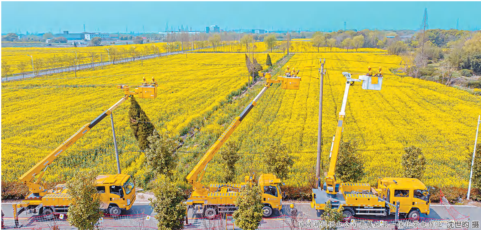
国网湖州供电公司开展地县一体化带电作业 沈世的摄
