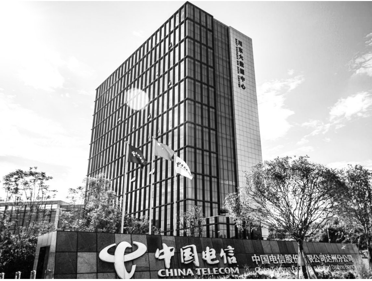
“东数西算”成渝枢纽的重要节点——川东大数据中心。
