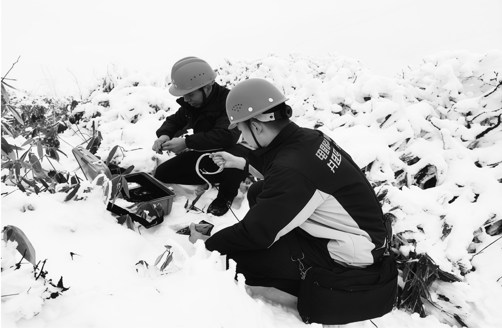
严寒天气下电信工作人员全力抢修设备，保障民生通信畅通。
