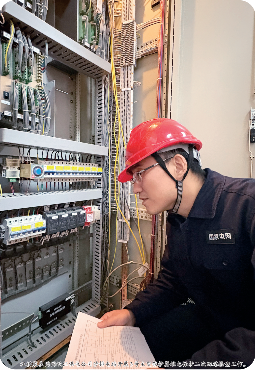
汪祺航在国网峨江供电公司沙排电站开展3号主变保护屏继电保护二次回路检查工作。
