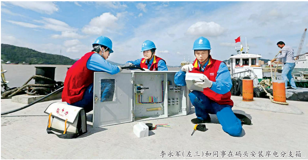
李永军(左三)和同事在码头安装岸电分支箱。
