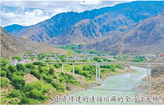
出资修建的连接川藏的金沙江大桥。
