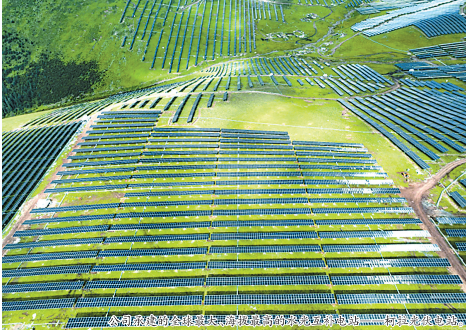
公司承建的全球最大、海拔最高的水光互补电站——柯拉光伏电站。
