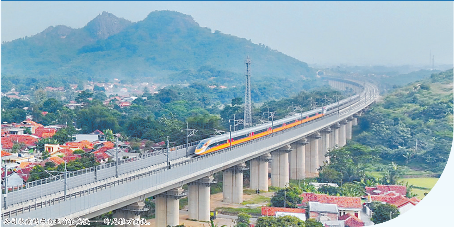
公司承建的东南亚首条高铁——印尼雅万高铁。
